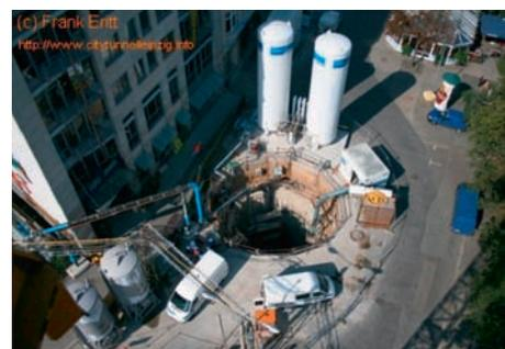
**Baugrundvereisung mit flüssigem Stickstoff (Foto: citytunnelleipzig)**
