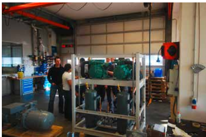
Fertigung von Verbundanlagen, Fischer Kälte-Klima AG.
