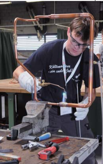
Stefan Wattinger bei Lötarbeiten am Cu-Rohrgebilde.
